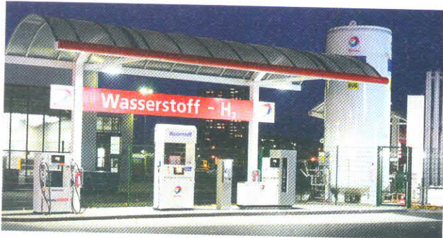
Wasserstofftankstelle der Total in Berlin.
